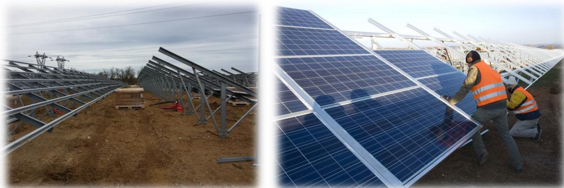
Montage des structures et pose des panneaux
