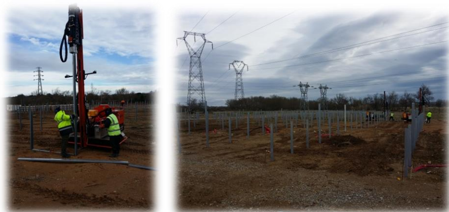
Mise en place des pieux battus
