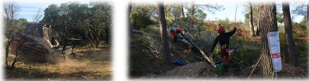
Exemple d'opérations de débroussaillage
