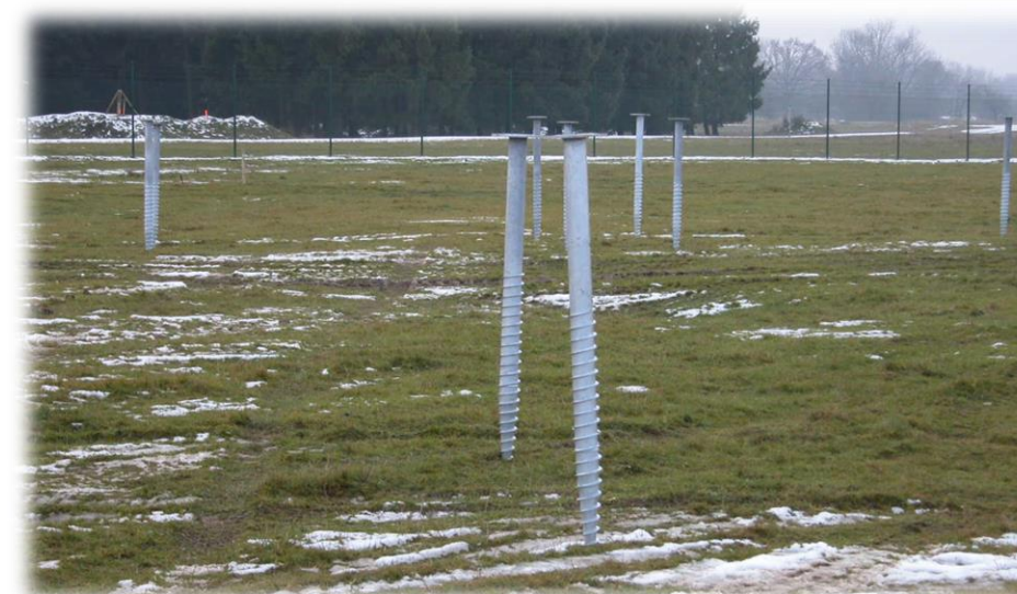
Exemple de pieux vissés avant enfoncement
