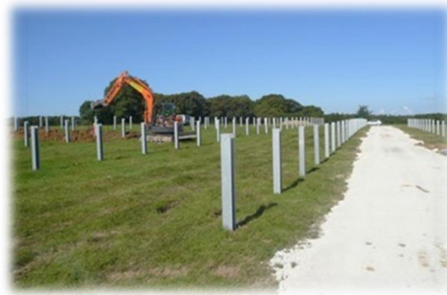
Exemple de voie d'accès en matériaux concassés
