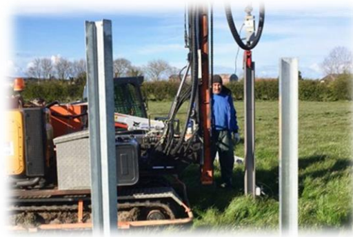
Exemple de batteuse de pieux (source mkg-goebel.de)
