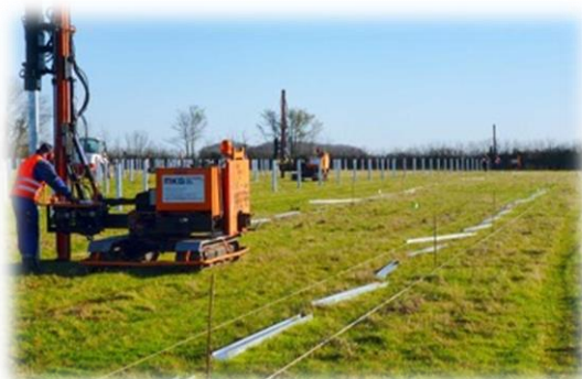
Exemple de batteuse de pieux (source mkg-goebel.de)
