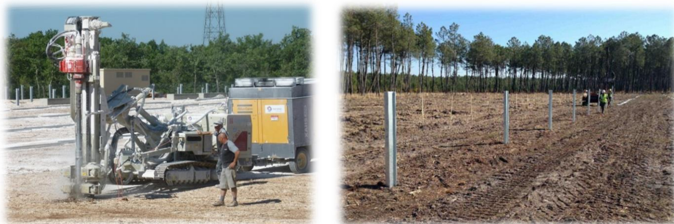
Illustration 4 - Ancrage au sol par pieux battus
