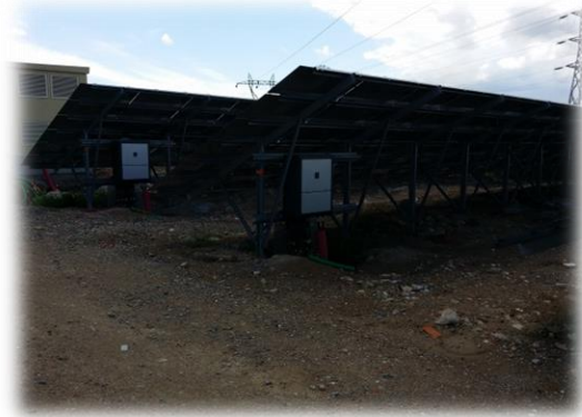
Illustration des équipements BT disposés en face arrière
