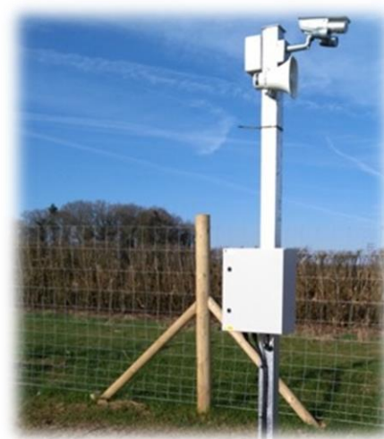
Exemple de dispositif de sécurité d'une clôture
