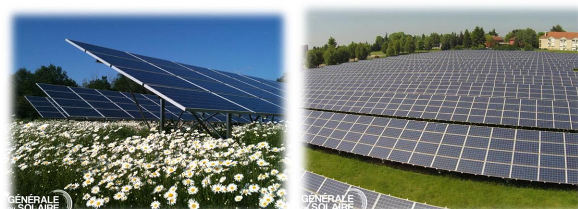
Exemple d'installation – Parc solaire de Sourdun (77)
